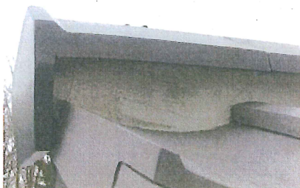
写真 3-2-4 いぶし瓦上部モルタル
