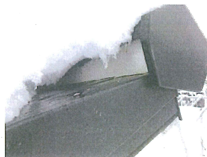
写真 3-1-5 FFタイプ上部モルタル
