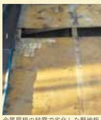
金属屋根の結露で劣化した野地板
