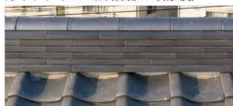
ガイドライン工法（棟部：改修後）
