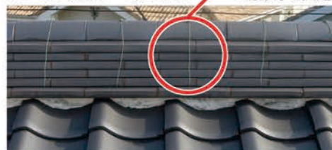
ガイドライン工法（棟部：改修後）
