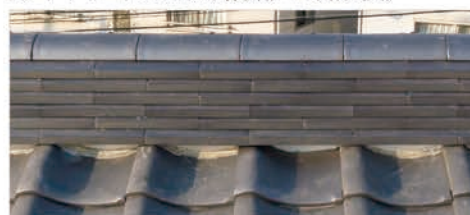
ガイドライン工法（棟部：改修後）
