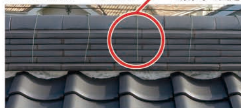
ガイドライン工法（棟部：改修後）
