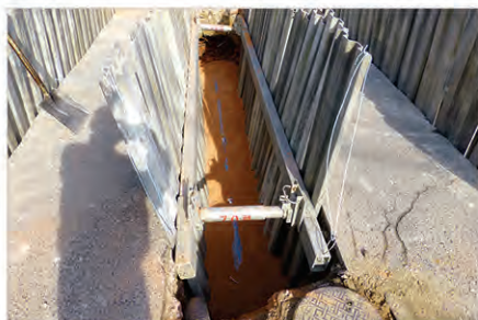
埋設管の埋戻実験
