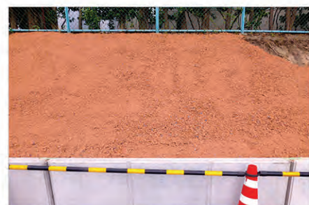
擁壁の裏込材
