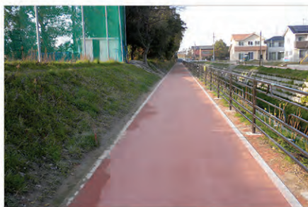
舗装材(固化材を用いた歩道)
