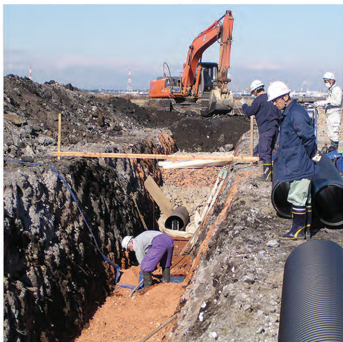
暗渠の埋戻材(埋立地)
