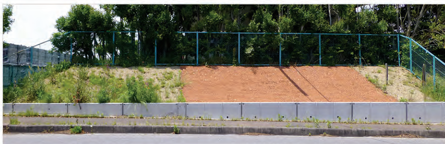
擁壁の裏込材・防草材(法面部分)
