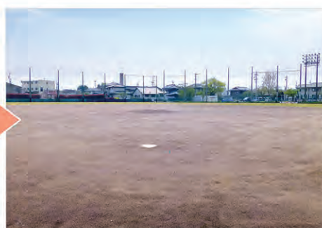
改修後の運動場(降雨の翌日)
